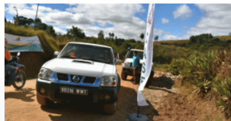
Le projet CASEF œuvre pour l'amélioration des infrastructures de transport, dans les zones à forte potentialité agricole.
