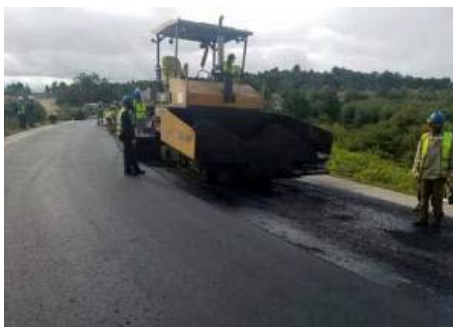
Grands chantiers de réhabilitation routière, dans la région Alaotra Mangoro.
