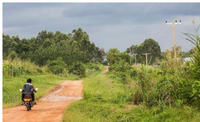
Projet électrification rurale - Ouganda
