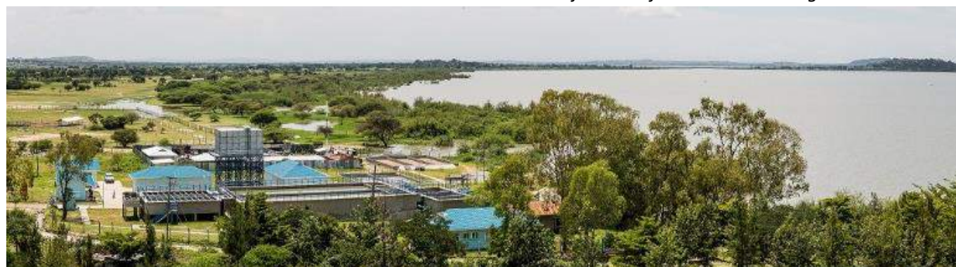
Financement d'un bloc sanitaire à Mwanza - Tanzanie
